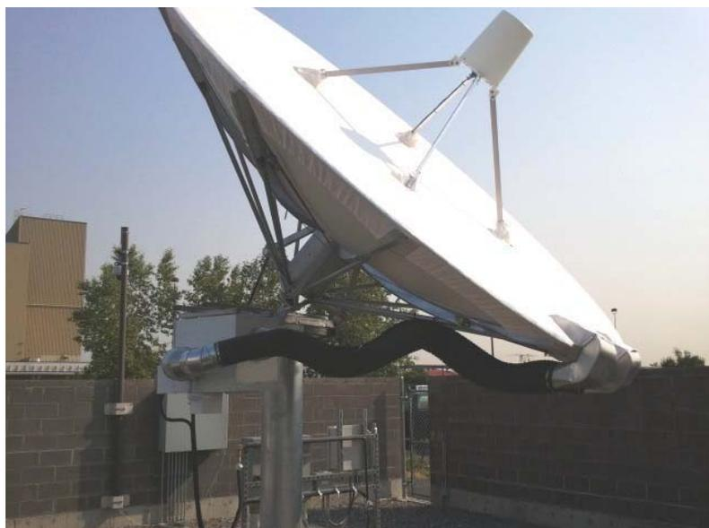
**Walton** 同时提供提供加热系统为 Snow Shield 和天线之间的空间充入加热的空气,确保在 Snow Shield 材料表面没有积雪。
